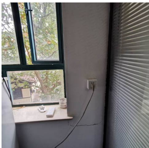
附照 19 三层 G*6-7 轴处墙体开裂
