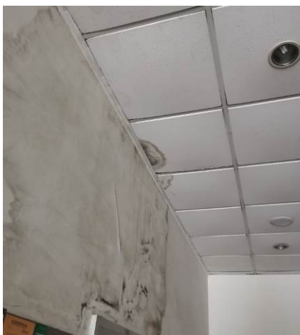
附照 7 一层走廊墙壁及吊顶渗水污染
