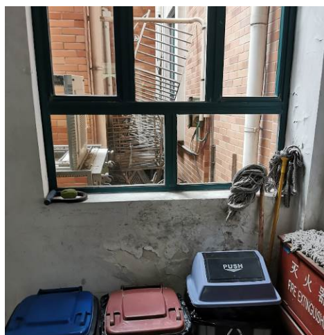
附照 8 一层 2*C-D 轴处墙体起皮、剥落
