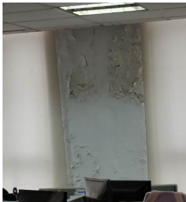
附照 29 四层 F-G*8 轴处墙体起皮、剥落
