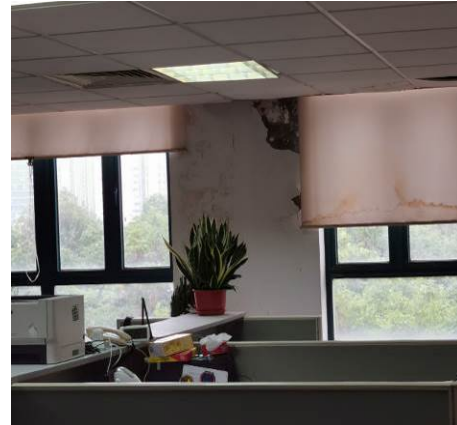
附照 28 四层 E-F*8 轴处墙体起皮、剥落
