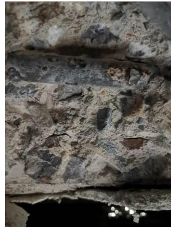
附照 26 开凿梁底检测钢筋配置
