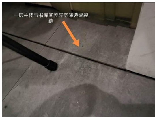
附照 20 二区与书库间一层地面出现明显差异沉降造成的裂缝
