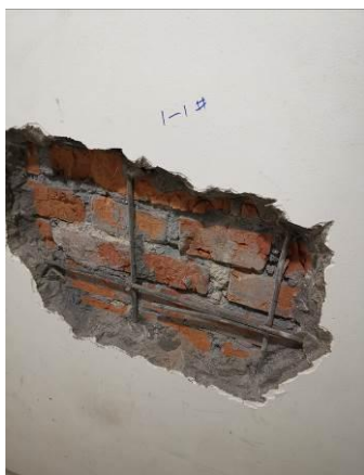
附照 23 墙面开凿检测砌体材料强度
