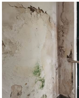
附照 24 三层楼梯间墙体严重发霉、起皮、剥落 2
