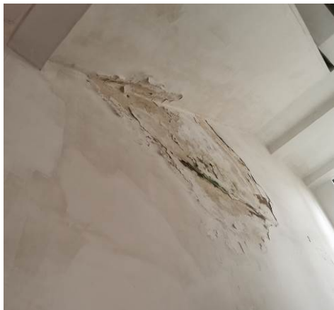
附照 9 一层楼梯间墙体严重发霉、起皮、剥落
