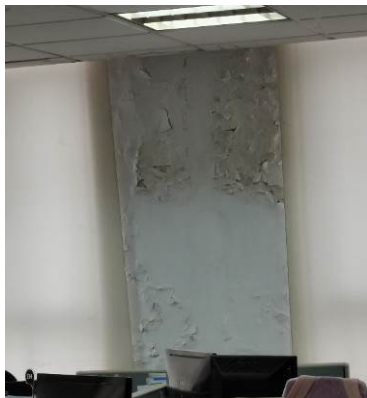
附照 29 四层 F-G*8 轴处墙体起皮、剥落
