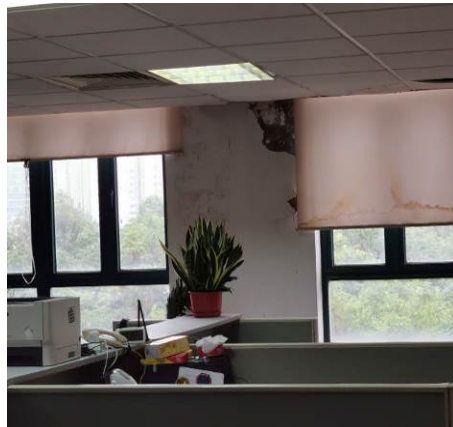
附照 28 四层 E-F*8 轴处墙体起皮、剥落
