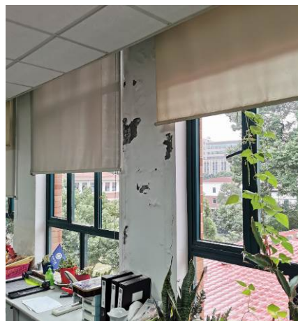
附照 22 三层 A*6-8 轴处墙体发霉、脱落
