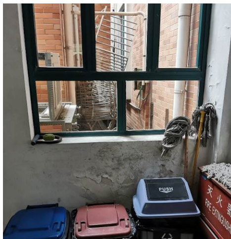
附照 8 一层 2*C-D 轴处墙体起皮、剥落
