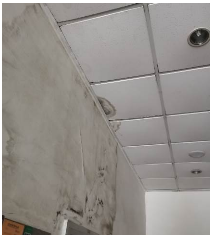
附照 7 一层走廊墙壁及吊顶渗水污染
